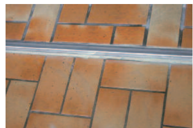
Damit nichts rostet – Schwellenschiene aus V2A
