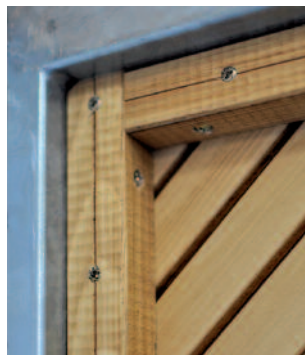
Flexible Befestigung des Torbelags mit Holzschraubleisten
