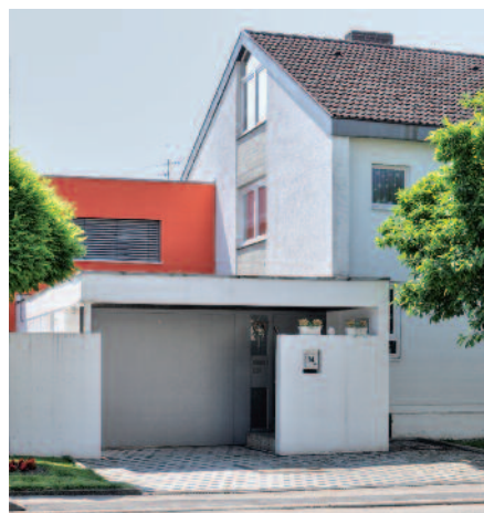
Kipptor mit lackierter Okoume-Bootsbauplatte
