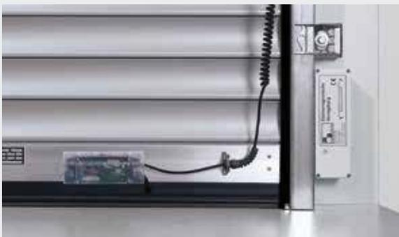
Die einbruchhemmenden Verschlüsse verriegeln das Bodenprofil mit den Führungsschienen.
