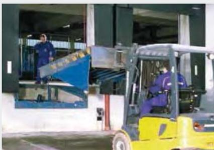
Alte Ladebrücke ausbauen, alten Basisrahmen demontieren und ggf. mit Adapterprofilen anpassen
