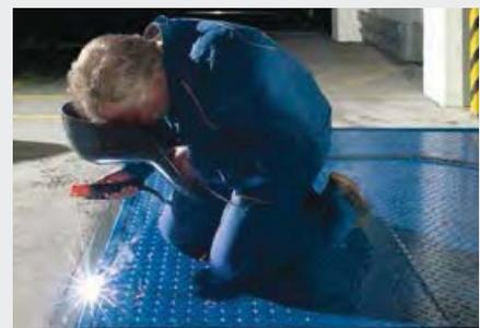
An die Randwinkel anschweißen – fertig!
